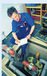
Der SHK-Fachmann prüft beim Trinkwassercheck Hausleitungen und Armaturen. FOTO: ZVSHK/TXN-P
